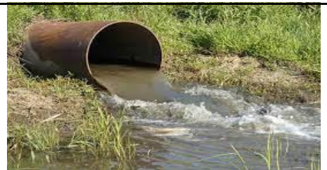
Contaminación de fuentes de agua con aguas residuales.
